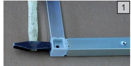
Die Bodenprofile des Gerätehauses werden gemeinsam mit den Bodenbefestigungswinkeln (z-förmig) mit den Sechskant-Blechschauben/Beilagscheiben am Bodenrahmen verschraubt.
