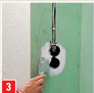
**3** **Steckdosenmontage:** Unterputzdose mit GLATTE SACHE einsetzen und beispachteln.
