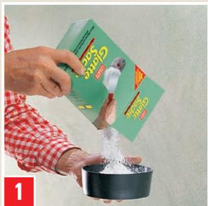
**1** GLATTE SACHE mit Wasser anmischen (1,5-1,8 Volumenteile : 1 VT Wasser). Verarbeitungszeit: 1 Stunde. Vor jeder neuen Mischung Werkzeug und Gefäß reinigen.
