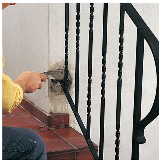
Typische Anwendung: Montage eines Treppengeländers.
