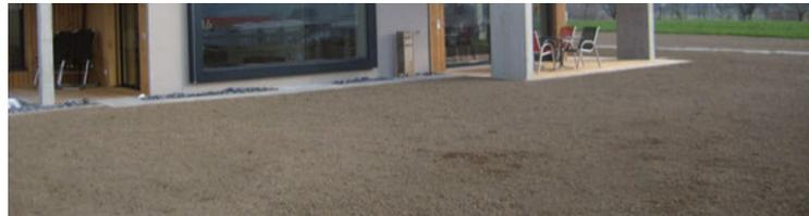
**4** Rollrasen bahweise versetzt verlegen. Fugen mit Druck aneinander stossen. Offene Fugen und Überlappen der Rasenbahnen vermeiden. Überstände mit scharfem Messer abschneiden.
