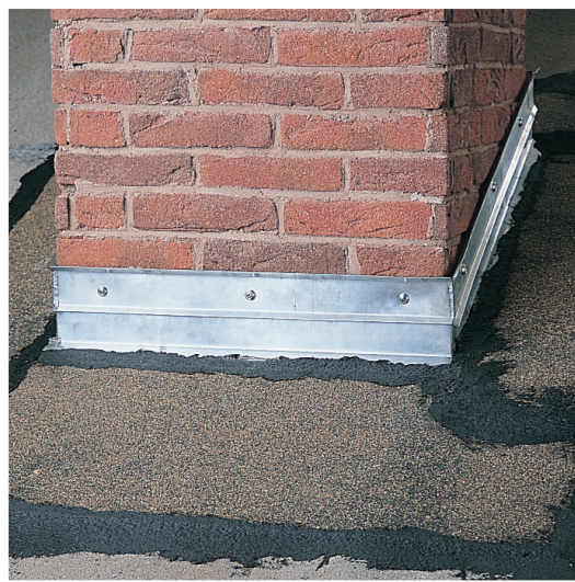
Kappeleiste am Schornstein mit SCHWARZER BLOCKER SPACHTELMASSE und Bitumenbahn abgedichtet.
