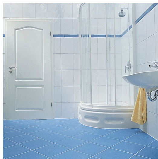
Die fertige Dusche. Eck- und Anschlussfugen elastisch abgedichtet.
