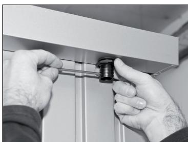
**1. Entfernen Sie das Auslaufstück und montieren Sie stattdessen den mitgelieferten Anschluss.**
